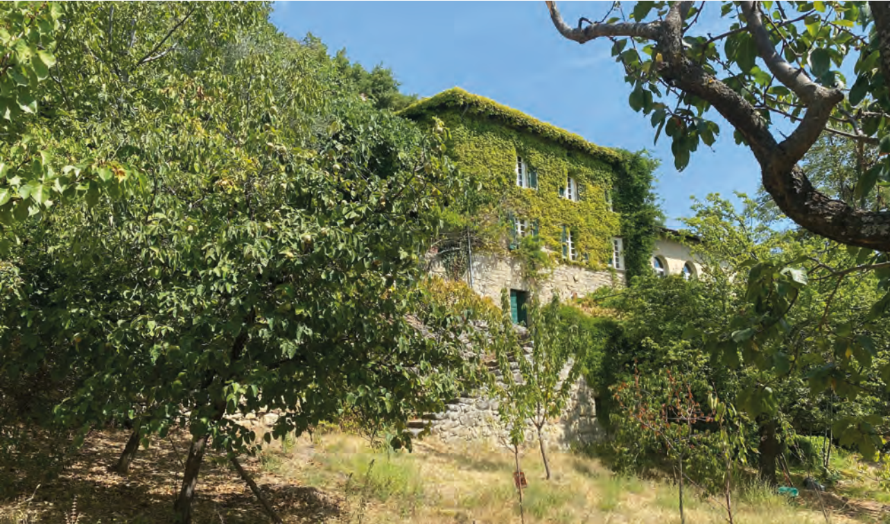
Fig. 8: il cosiddetto "Palazzo Galanti" alla base della zona con terrazzamenti, nella parte alta di Livelli (Bagnaria). In questo edificio (un fondaco) è possibile che fino ai primi decenni del '900 fosse presente e attivo un piccolo frantoio ad uso familiare.
